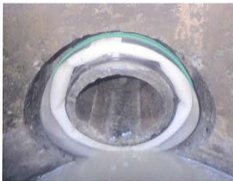
耐震可とう継手設置完了
