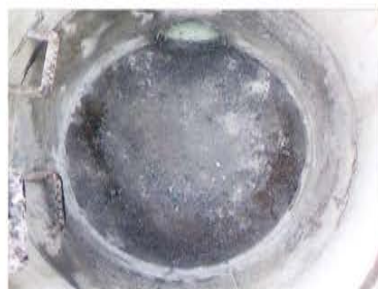
インバート壊し完了
