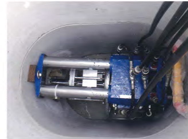
写真-3 切削機設置状況（楕円 900 mm × 600 mm）
