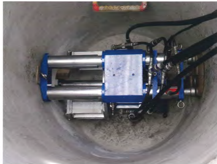
写真-1 切削機設置状況
