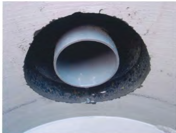
写真-2 切削完了状況
